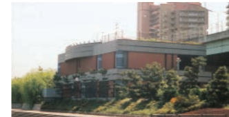
八轩川泵场 (泉大津市)
